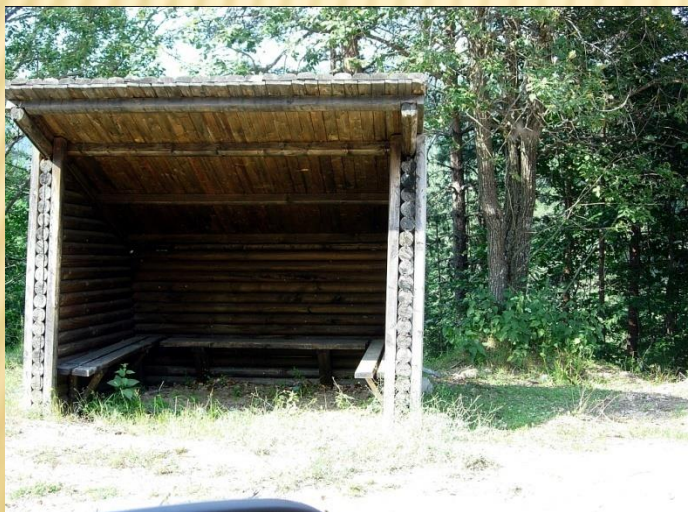
Υπόστεγο από στυλούς πεύκου (ορεινή δασική περιοχή Ν. Σερρών)
