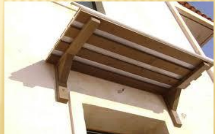
Σκέπαστρο εισόδου (με πολυκαρβονικό)
