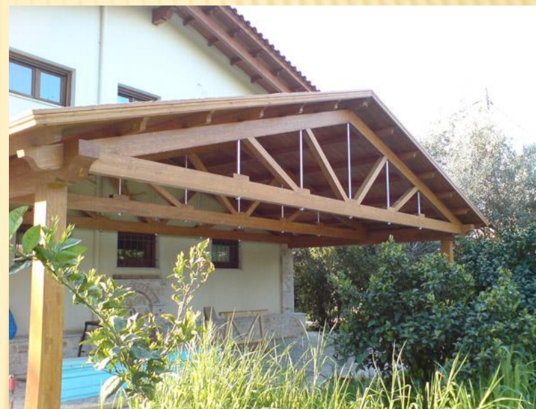
Υπόστεγο χωρίς ενδιάμεση κολώνα
