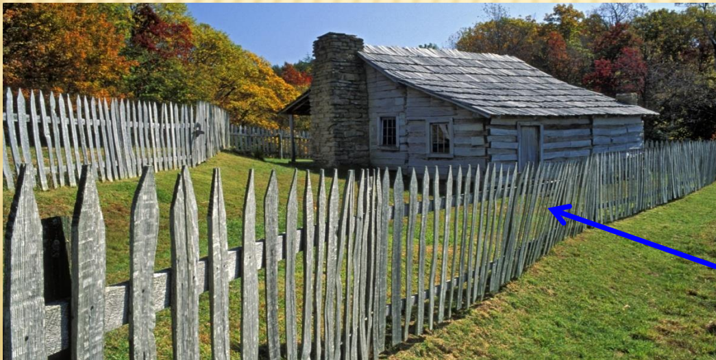
Σταθερός φράκτης οικίας από κατακόρυφες σανίδες
