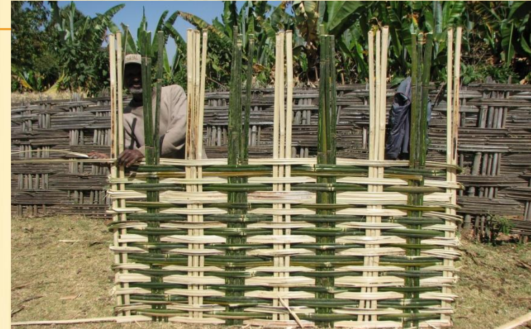
Κατασκευή πλεκτής περιφραξης από μπαμπού
