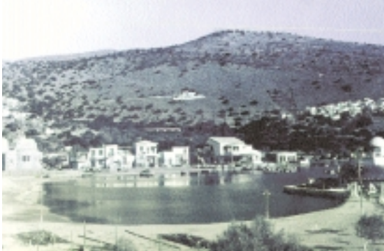
φωτ. 4.1 Λιμάνι, Ελούντα Κρήτης, 1963
