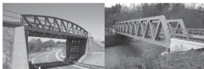
Εικόνες 3 και 4: Παραδείγματα γεφυρών με τραβέρσες (truss bridges). Πηγή: Railway bridges. Top Con Service [online]. 1992-2011 [cited. 02.19.2012]. Διαθέσιμη από την ιστοσελίδα: http://www.topcon.cz/reference/railway-mosty.htm
