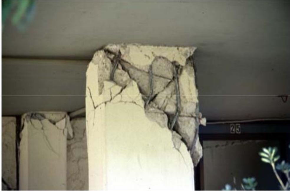
Φωτ. 9 (αρ.): Διατμητική αστοχία υποστυλώματος με λυγισμό ράβδων και θραύση λεπτών & αραιών συνδετήρων Σχ. 1 (δεξ.): Απαιτούμενη συγκράτηση κατακόρυφων οπλισμών υποστυλώματος με πολλαπλούς συνδετήρες κατά ΕΚΩΣ 2000
