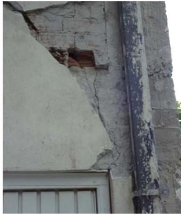
Φωτ. 1 (αρ.): Αποφλοίωση σκυροδέματος επικάλυψης Φωτ. 2,3 (μέσο & δεξ.): Ανεπαρκής αγκύρωση πάνω & κάτω ράβδων δοκού
