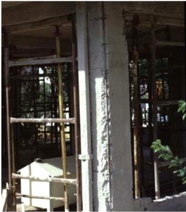
Φωτ. 1 (αρ.): Αποφλοίωση σκυροδέματος επικάλυψης Φωτ. 2,3 (μέσο & δεξ.): Ανεπαρκής αγκύρωση πάνω & κάτω ράβδων δοκού
