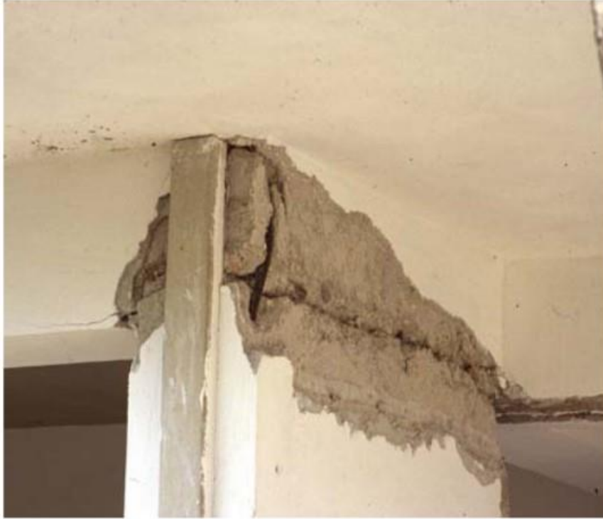
Φωτ. 4 (αρ.): Ανεπαρκής αγκύρωση κάτω ράβδων δοκού λόγω σκυροδέτησης υποστυλώματος πάνω από τη μασχάλη δοκού Φωτ. 5 (δεξ.): Διάρρηξη απερίσφιγκτου σκυροδέματος κόμβου (Fib Bulletin 24)
