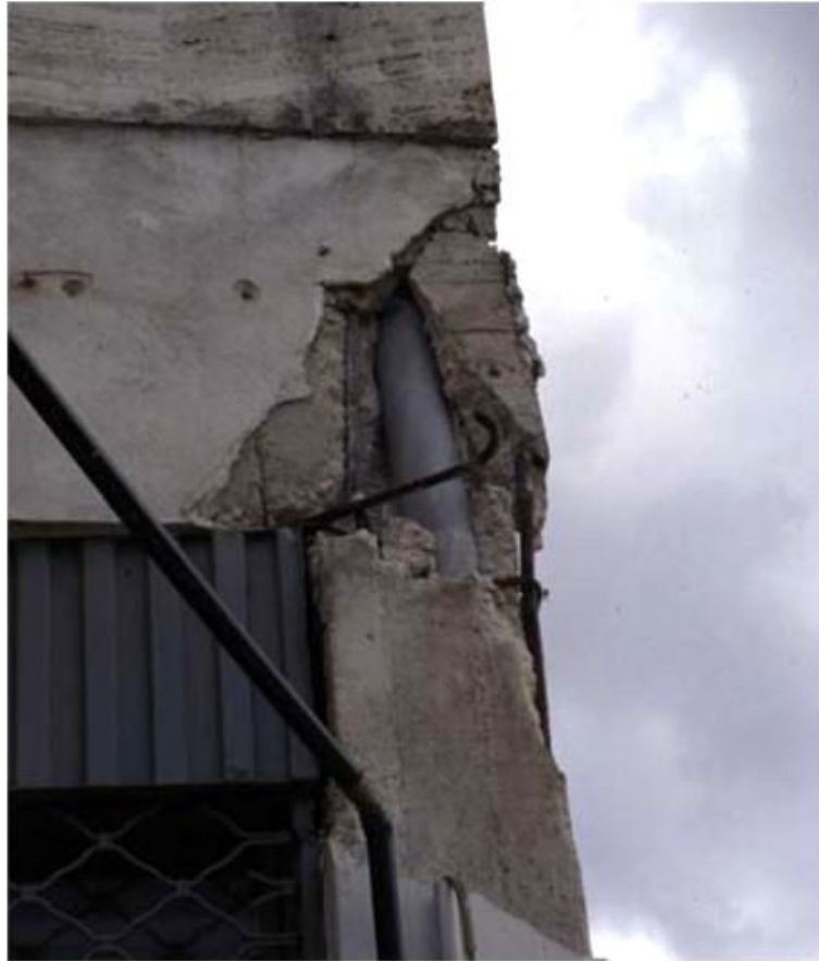
Φωτ. 23 (αρ.): Αστοχία κόμβου και απώλεια περίσφιγξης συνδετήρων λόγω τοποθέτησης υδρορρόης εντός του υποστυλώματος Φωτ. 24 (δεξ.): Εμβολισμός υποστυλώματος από την πλάκα γειτονικού χαμηλότερου κτιρίου
