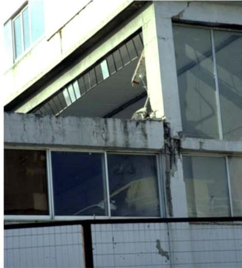
Φωτ. 23 (αρ.): Αστοχία κόμβου και απώλεια περίσφιγξης συνδετήρων λόγω τοποθέτησης υδρορρόης εντός του υποστυλώματος Φωτ. 24 (δεξ.): Εμβολισμός υποστυλώματος από την πλάκα γειτονικού χαμηλότερου κτιρίου
