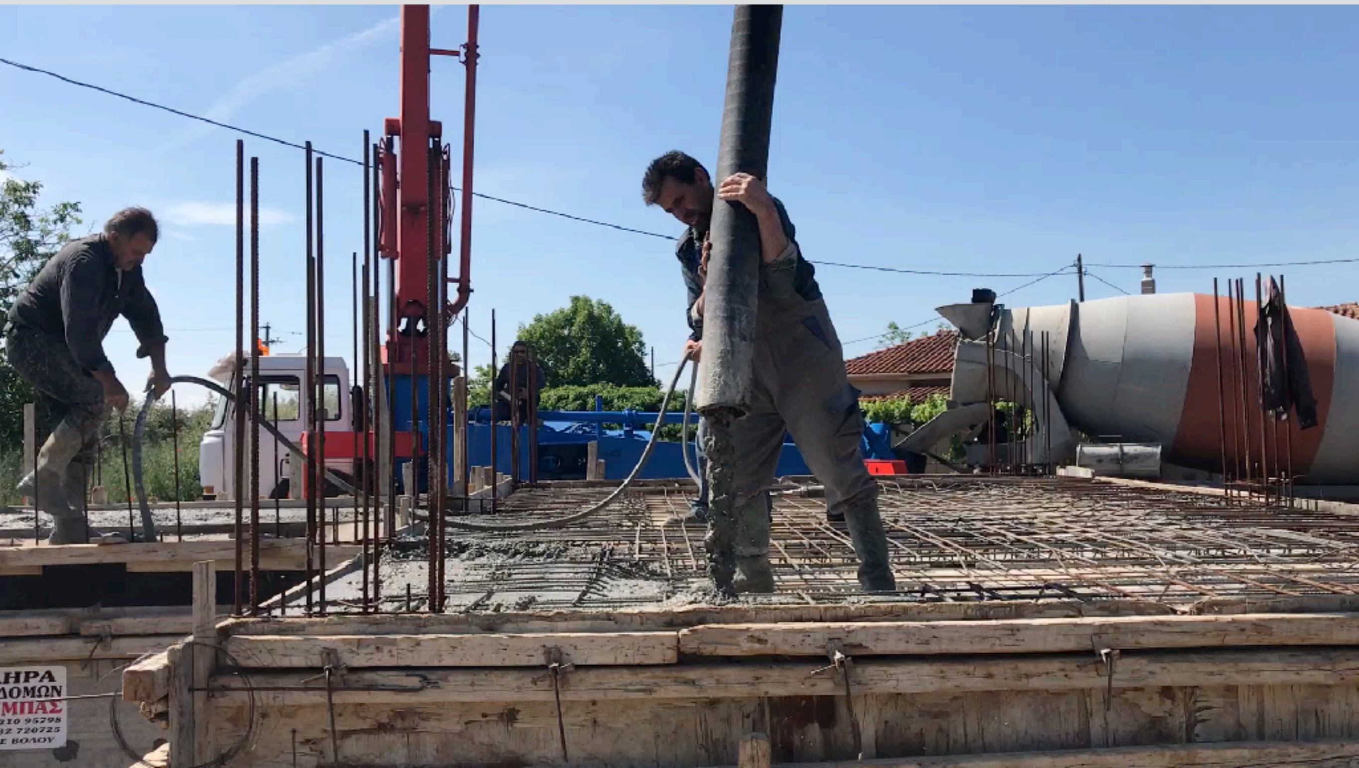
Σκυροδέτηση οικοδομικού σκελετού
