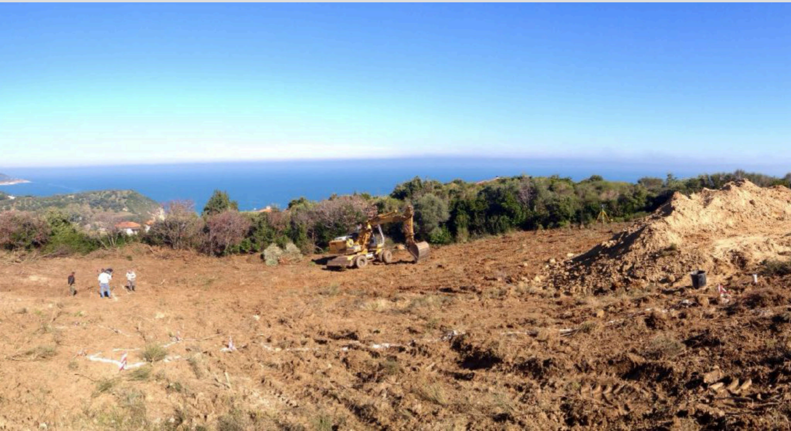
Χάραξη του περιγράμματος της οικοδομής
