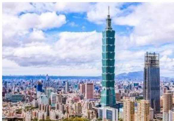
Εικόνα 2: Το κτίριο Taipei 101
