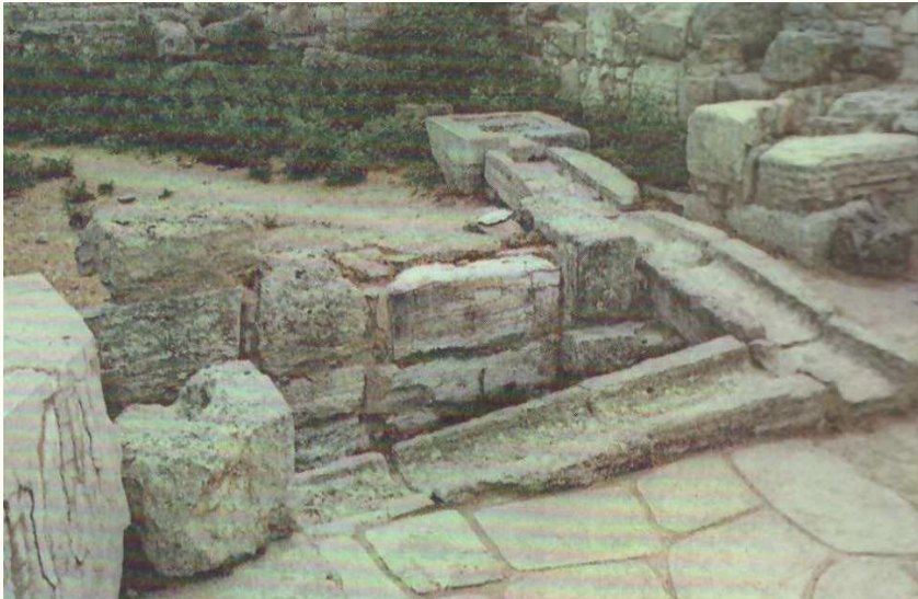
Τμήμα αποχετευτικού συστήματος της Κνωσού.
