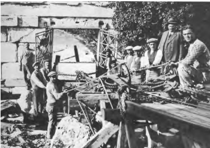
Μεταφορά μελών κατά τις αναστηλωτικές εργασίες Ν. Μπαλάνου (Μαλλούχου-Τυφانو 1998).
