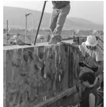
Από τις εργασίες αποσυναρμολόγησης και μεταφοράς της δυτικής ζωφόρου του Παρθενώνα στο Παλιό Μουσείο Ακρόπολης, 1992 (Αρχείο ΥΣΜΑ).
