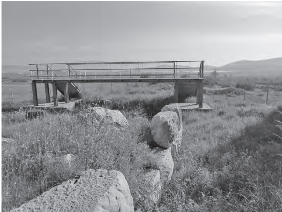
Εικ. 3. Άλος. Το νότιο σκέλος του τείχους πριν τις εργασίες καθαρισμού.
