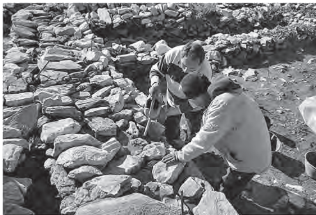
Εικ. 5. Εργασίες συντήρησης των λιθόκτιστων τοίχων (ενίσχυση με συνδετικό κονίαμα).
