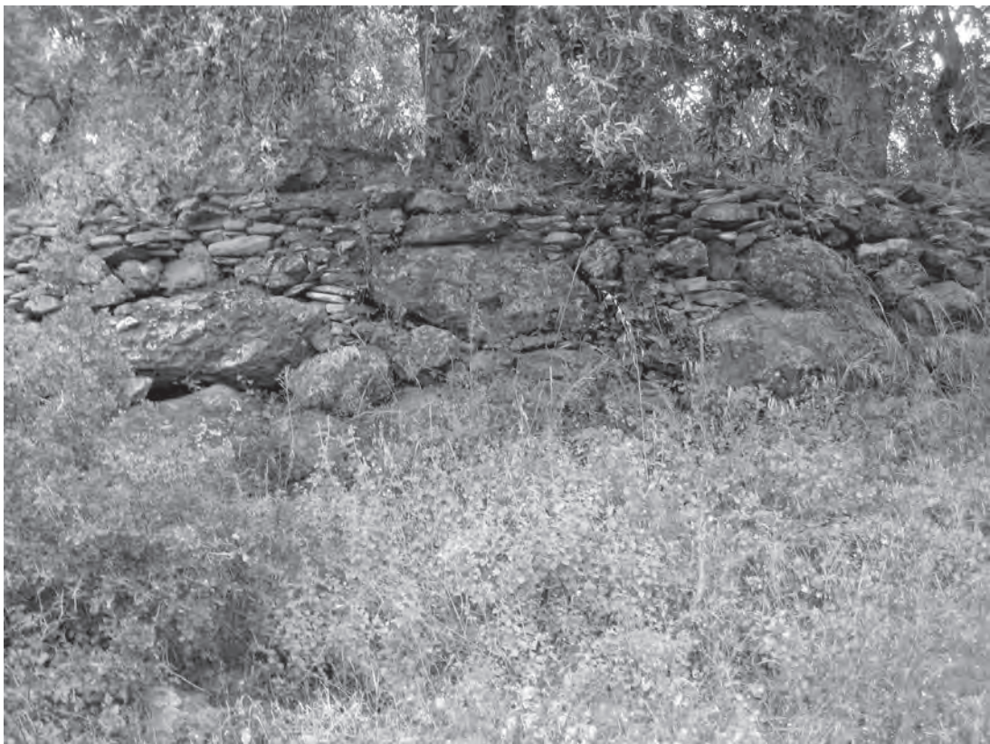
Εικ. 4. Τμήμα του τείχους-αναλήμματος στη θέση «Πετράλωνα»
