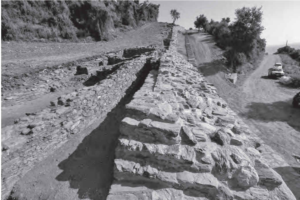
Εικ. 4. Περίδρομος και κλίμακα στην ανατολική πλευρά.
