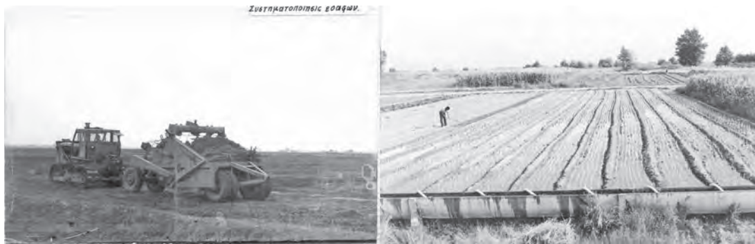
Εικ. 3. Αναδασμός στον Κάμπο. Ισοπεδώσεις και μετακίνηση χώματος, άρδευση με κατάκλυση (Φωτογραφικό Αρχείο της Περιφέρειας Θεσσαλίας).
