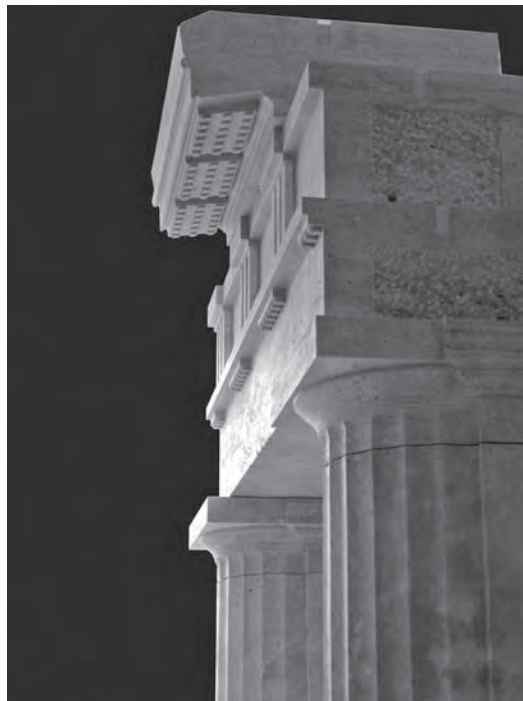
Εικ. 6. Φωτογραφία ανακατασκευασμένου τμήματος του προσκηνίου.
