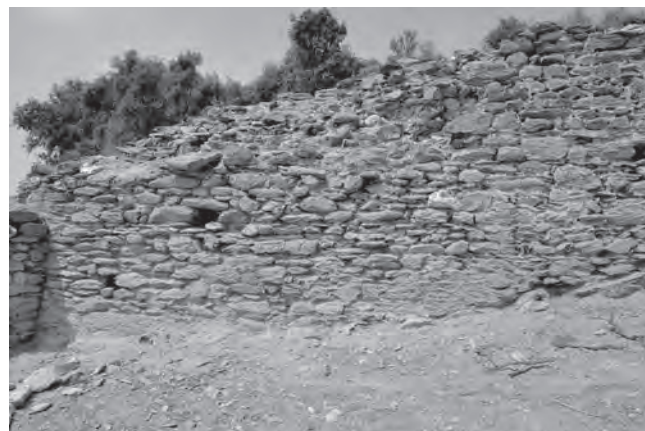
Εικ. 10. Άποψη της ανατολικής πλευράς.
