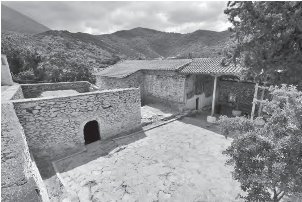
Εικ. 1. Άποψη ναού και κρύπτης από ΒΔ πριν τις εργασίες.
