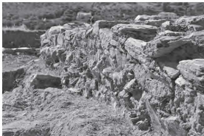
Εικ. 15. Ο Νότιος τοίχος T13 του Κτιρίου Β από ΝΑ.
