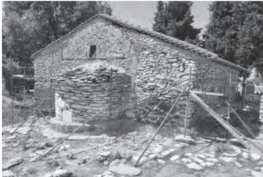
Εικ. 3. Η ανατολική όψη του ναού μετά την καθαίρεση των επιχρισμάτων και αρμολογημάτων.
