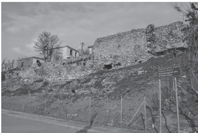
Εικ. 2. Κάστρο Βόλου. Νοτιοδυτική πλευρά.
