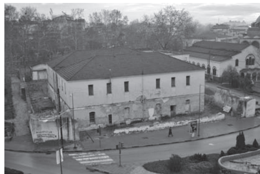
Εικ. 11. Τρίκαλα. Κτίριο πρώην ποινικών φυλακών. Άποψη από δυτικά του αποκαλυφθέντος οθωμανικού λουτρού.
