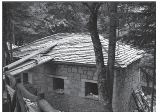
Εικ. 6. Κτίριο χώρων υγιεινής.
