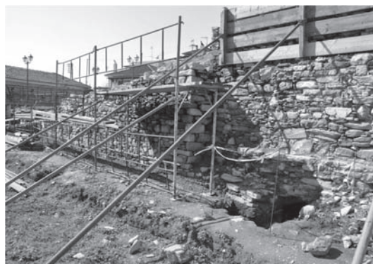
Εικ. 12. Κάστρο Βόλου. Βορειοανατολική πλευρά. Κατά τις εργασίες συντήρησης και αποκατάστασης.
