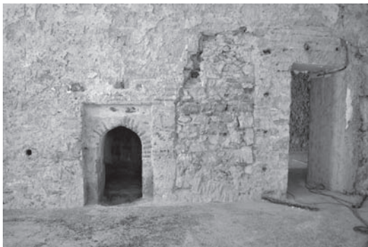
Εικ. 5. Θερμός χώρος ανδρών, θύρα εισόδου και κόγχη «μυχράμπ».
