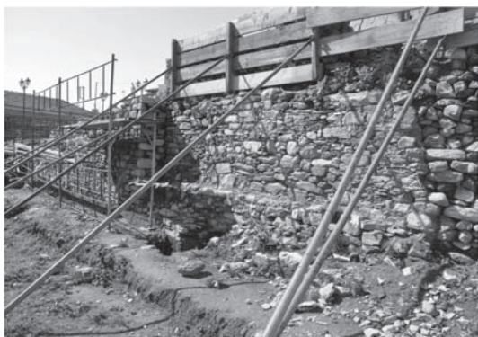
Εικ. 11. Κάστρο Βόλου. Βορειοανατολική πλευρά. Κατά τις εργασίες συντήρησης και αποκατάστασης.
