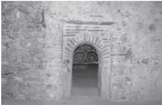
Εικ. 11α. Τρίκαλα. Κτίριο πρώην ποινικών φυλακών. Οθωμανικό λουτρό. Γυναικείο τμήμα. Θύρα επικοινωνίας χλιαρού και θερμού χώρου.
