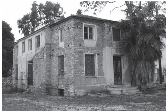
Εικ. 1. Η νότια και η ανατολική όψη. Υπάρχουσα κατάσταση.
