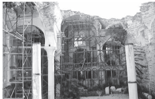
Εικ. 3. Εσωτερικό ναού (προς Α.), πριν την αποκατάσταση.
