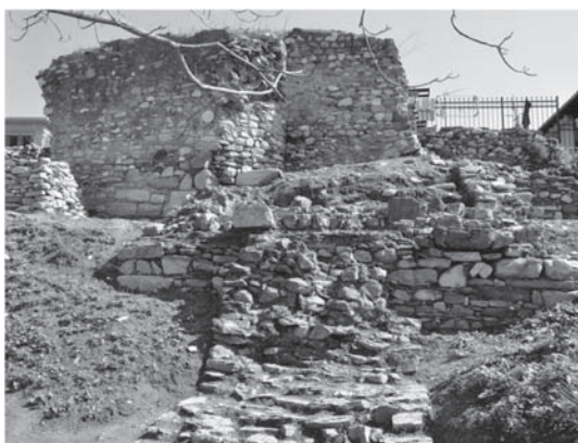
Εικ. 9. Κάστρο Βόλου. Νοτιοδυτική πλευρά του τείχους. Πύργος και αντηρίδα.
