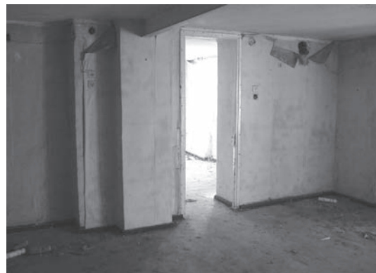
Εικ. 8. Άποψη του ορόφου. Υπάρχουσα κατάσταση.
