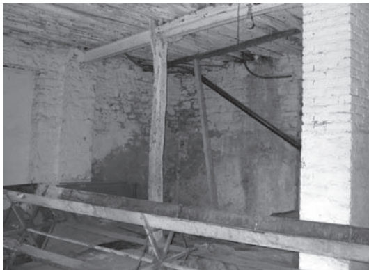
Εικ. 7. Άποψη του ισογείου. Υπάρχουσα κατάσταση.
