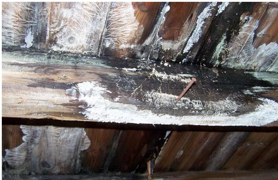
ΕΙΚΟΝΑ 3B. Τυπική εμφάνιση καστανής σήψης σε ξύλο.
