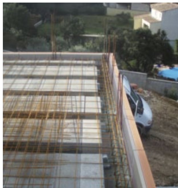
Plancher bas sur terre-plein avec dalle pleine
