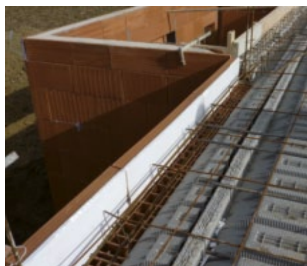
Plancher bas sur terre-plein avec dalle pleine
