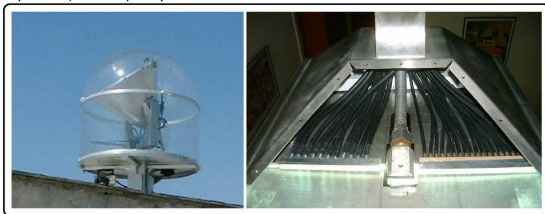
Σχήμα 7.105: Μεταφορά φυσικού φωτισμού με υγρή οπτική ίνα.
