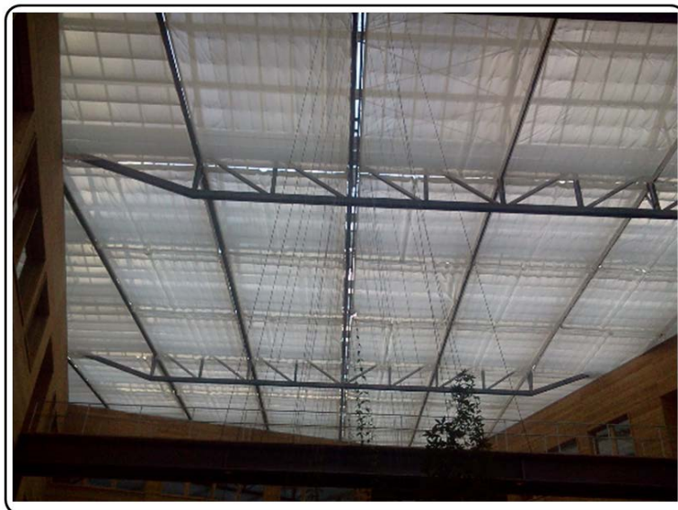
Σχήμα 7.20: Χρήση εσωτερικής σκίασης αιθρίου.
