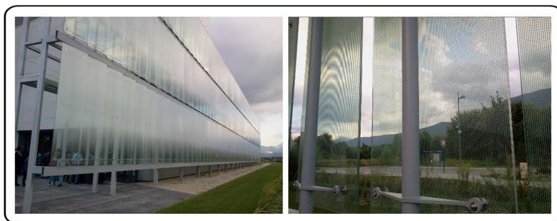
Σχήμα 7.67: Η υιοθέτηση αυτών των συστημάτων επιτρέπει την διατήρηση της οπτικής επαφής με το εξωτερικό περιβάλλον και ταυτόχρονα (ανάλογα με την πυκνότητα του σχεδίου) τη μείωση των ηλιακών κερδών.
