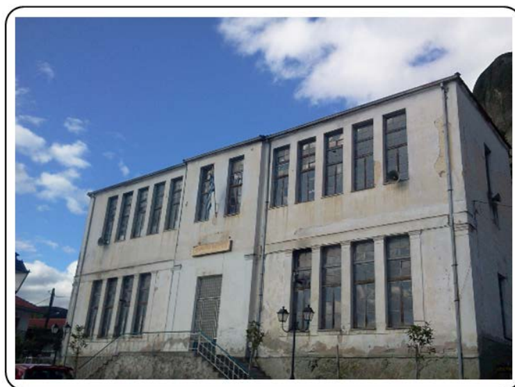
Σχήμα 6.14: Χρήση ανοιγμάτων με αυξημένη κατακόρυφη διάσταση.
