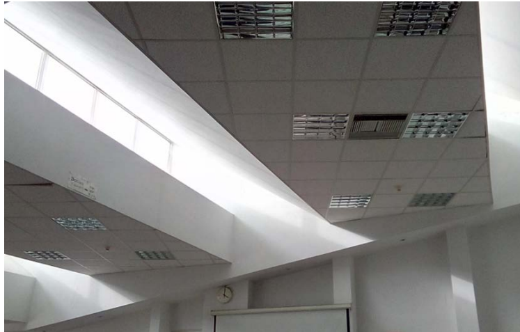
Σχήμα 7.41: Χρήση διαδοχικών φεγγιτών στο δώμα. Ένα αποτέλεσμα της συγκεκριμένης λύσης είναι η επίτευξη ομοιομορφίας φωτισμού.
