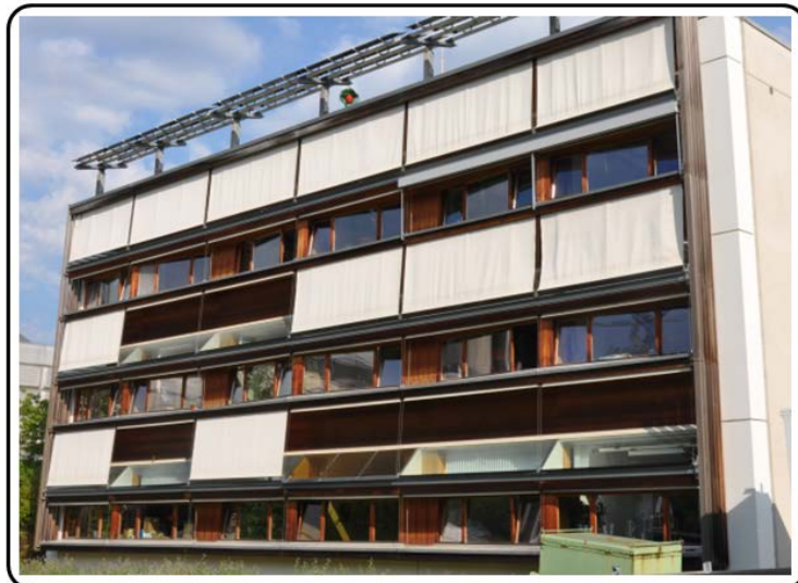
Σχήμα 7.76: Κτήριο με εγκατεστημένο ανειδωλικό σύστημα φυσικού φωτισμού. Φωτ. Α. Δράκου, TAM, ΠΘ.
