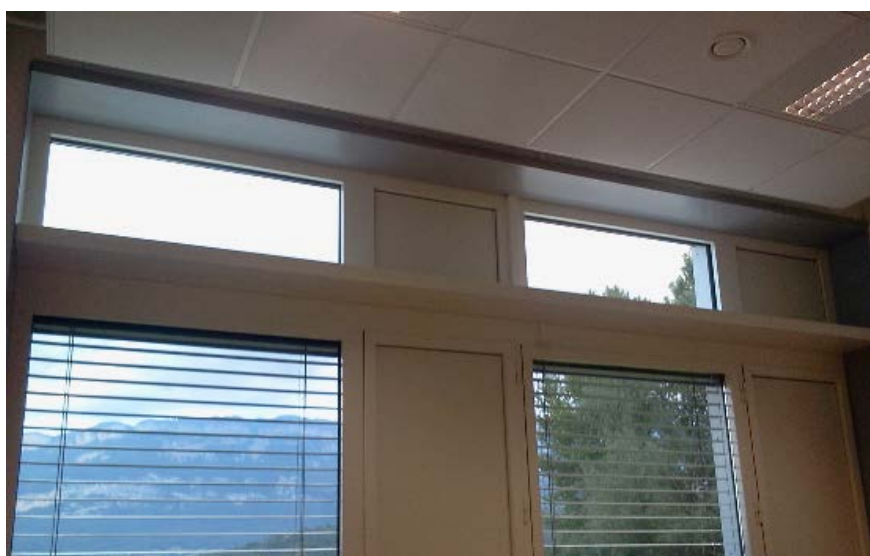
Σχήμα 7.70: Εξωτερικό και εσωτερικό ράφι φωτισμού.
