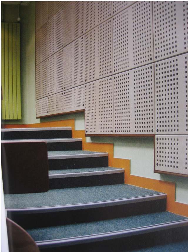
174 PLAQUES PERFORÉES CHACUNE DE 256 TROUS assurent la correction acoustique recherchée. Chaque bétonnage a été réalisé avec une précision de l'ordre du millimètre. L'objectif était de ramener les durées de réverbération à un seuil autour de 0,6 s. (Docs. DR.)
