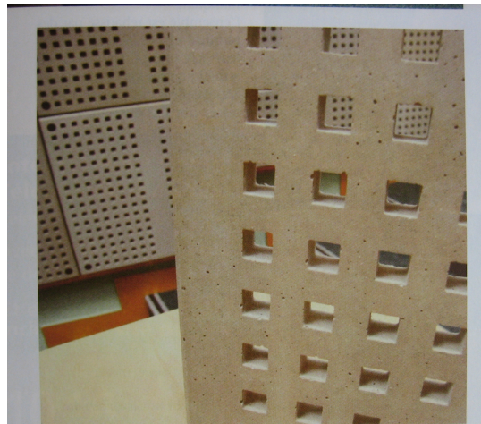
174 PLAQUES PERFORÉES CHACUNE DE 256 TROUS assurent la correction acoustique recherchée. Chaque bétonnage a été réalisé avec une précision de l'ordre du millimètre. L'objectif était de ramener les durées de réverbération à un seuil autour de 0,6 s. (Docs. DR.)
