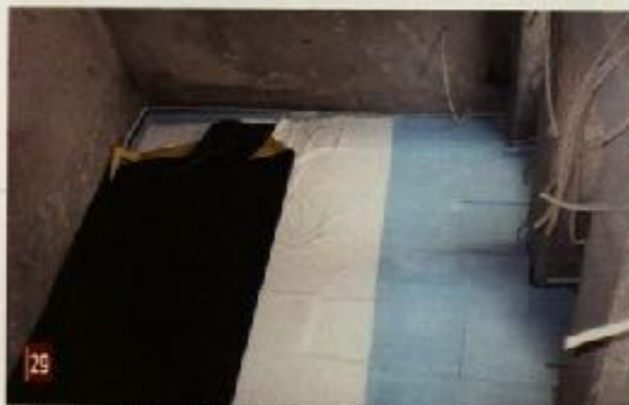
29. Άποψη στρώσεων υλικών μόνωσης υπογείου. 29. Laying materials for the insulation of the basement.
