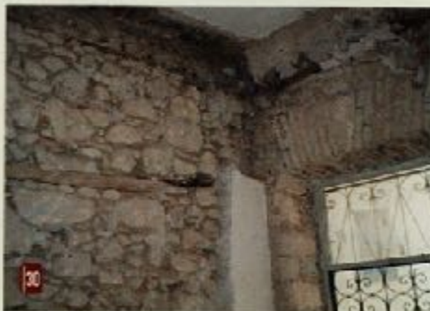
30. Άποψη εσωτερικής τοιχοποιίας και ανώγειου μετά την καθάρση των παλιών επικρισμάτων. 30. A detail of an interior masonry and of an ceiling, after the removal of the old coatings.
