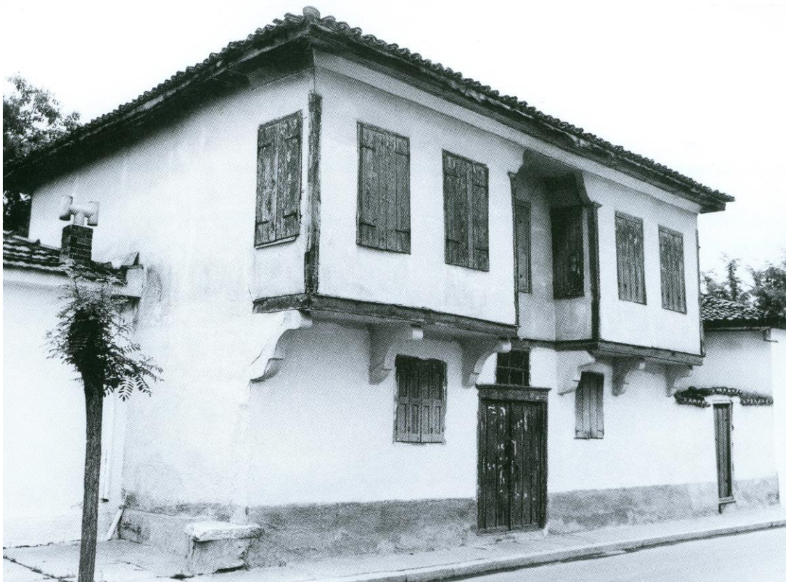
Χαρακτηριστικά τα "σαχνισιά" της οικίας Γερολυμάτου, που σώζεται, σε κακή όμως κατάσταση, στην οδό Γ. Σεφέρη.
