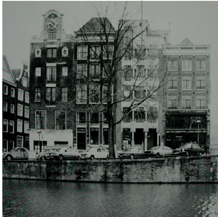
Κτίριο γραφείων και κατοικιών, Άμστερνταμ, 1971, αρχιτ. Άμπελ Κάχεν
