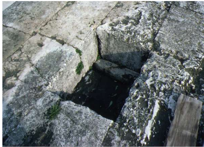
2. Η δοκοθήκη εντός του δαπέδου του Παρθενώνα, στην οποία στηριζόταν η ξύλινη δοκός/άξονας του ξύλινου σκελετού του αγάλματος.
