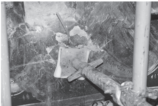
Εικ. 6. Εξάσκηση πίεσης στην αποκολλημένη επιφάνεια.
