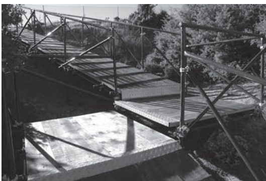
Εικ. 5. Κατασκευή αντιστρεπτού διαδρόμου ενοποίησης αρχαιολογικού χώρου Σαρανταπόρου.
