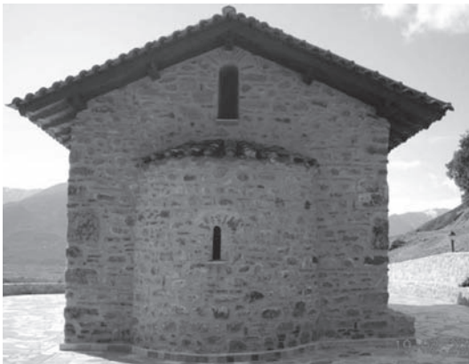
Εικ. 3. Καστράκι Καλαμπάκας, Παναγία Δούπιανης, Ανατολική πλευρά. Η κόγχη του ναού μετά την αποκατάσταση.
