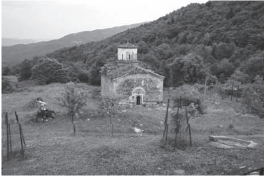
Εικ. 1. Καστανιά Καλαμπάκας. Ι. Μ. Αγ. Νικολάου Σιαμάδων. Γενική άποψη του ναού πριν την αποκατάσταση.
