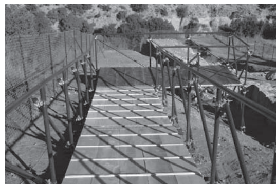
Εικ. 6. Κατασκευή αντιστρεπτού διαδρόμου – πλατώματος θέασης στον αρχαιολογικό χώρο Σαρανταπόρου.
