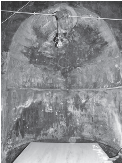
Εικ. 3α. Κόγχη Ιερού. Τμήμα ασυντήρητης τοιχογραφίας με θέμα την Πλατυτέρα και τους Ιεράρχες, στην οποία παρατηρούνται εκτεταμένες φθορές όπως επιχρίσματα βερνικιών, επικαθήσεις αλάτων και αιθάλης, αποκολλήσεις υπο-
