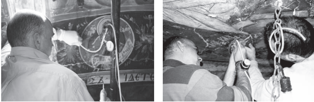
Εικ. 4. Ενέματα με χρήση ειδικής συσκευής ενεμάτων για τοιχογραφίες. Διακρίνεται το μανόμετρο με το οποίο ελέγχεται συνεχώς η πίεση του ενέματος στην τοιχογραφία, ενώ μέσω ενσύρματου χειριστηρίου ρυθμίζεται η ποσότητα και η κατεύθυνση του υλικού.
