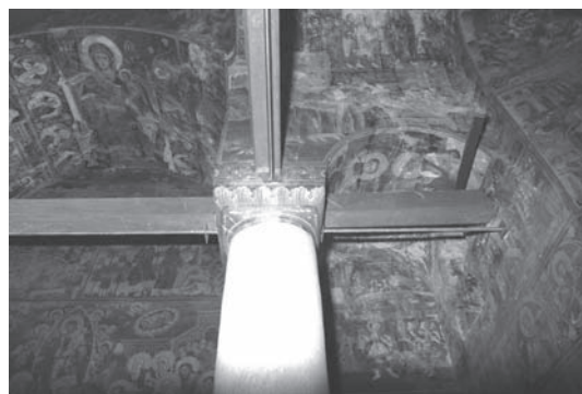
Εικ. 8. Καστανιά Καλαμπάκας. Ι. Μ. Αγ. Νικολάου Σιαμάδων. Τοποθέτηση μεταλλικών ελκυστήρων.
