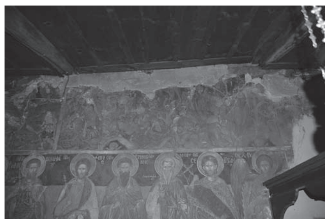
Εικ. 4. Παρεκκλήσιο Αγίων Αναργύρων. Βόρειος τοίχος.
