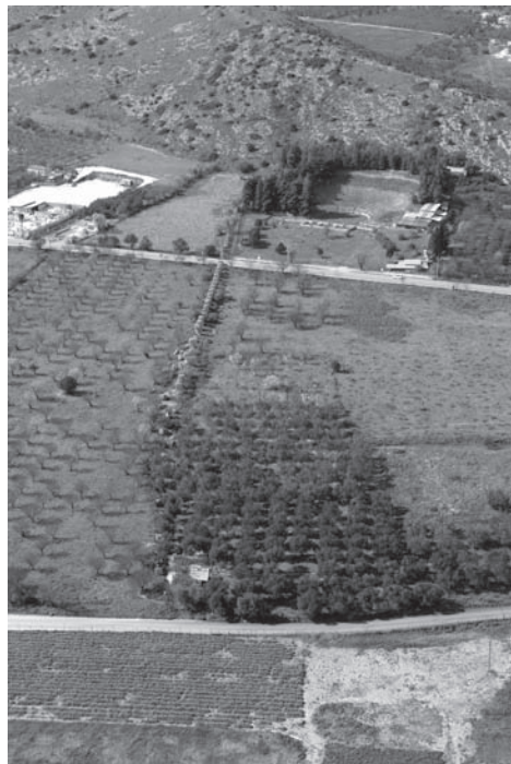
Εικ. 2. Οι πεσσοί του ρωμαϊκού Υδραγωγείου.
