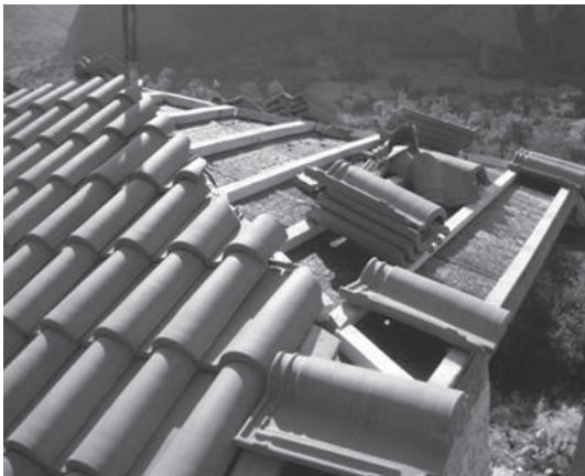
Εικ. 8. Καστράκι Καλαμπάκας Παναγία Δούπιανη. Εργασίες αποκατάστασης της στέγης του ναού.
