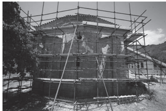
Εικ. 5, 6. Καστανιά Καλαμπάκας. Ι. Μ. Αγ. Νικολάου Σιαμάδων. Εργασίες υποστήριξης – αντιστήριξης εξωτερικά του ναού.
