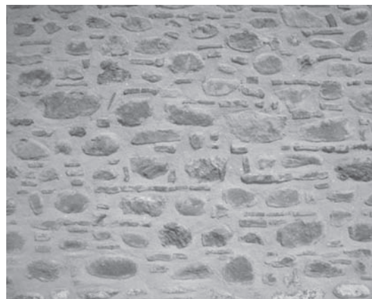
Εικ. 9. Καστράκι Καλαμπάκας Παναγία Δούπιανη. Εργασίες ενίσχυσης της τοιχοποιίας με νέο αρμολόγημα.
