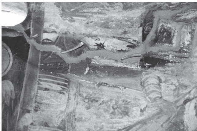
Εικ. 3. Στοκαρίσματα και αναμονές για το ένεμα.
