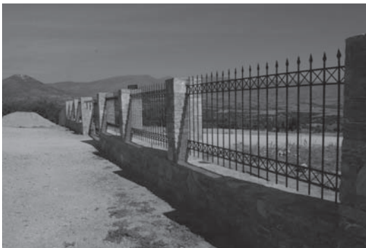
Εικ. 3. Σηματοδότηση αρχαιολογικού χώρου με την κατασκευή λιθόκτιστης εισόδου.
