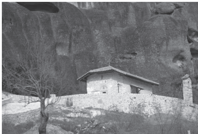
Εικ.10. Καστράκι Καλαμπάκας Παναγία Δούπιανη. Γενική άποψη του ναού μετά την αποκατάσταση.
