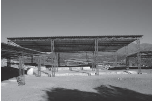
Εικ. 1. Νέα αντιστρέψιμα στέγαστρα προστασίας στον χώρο Σαρανταπόρου.
