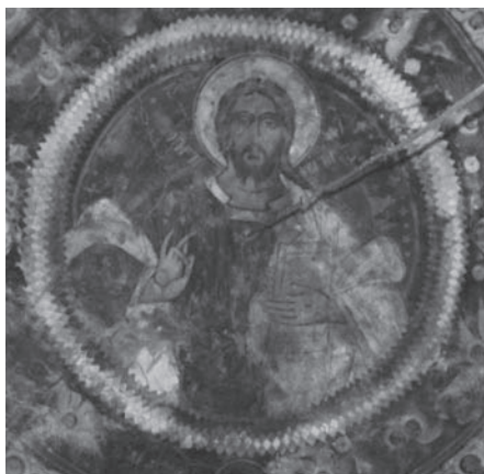
Εικ. 1. Φουσκαωμένη -αποκολλημένη από τη λιθοδομή τοιχογραφία.
