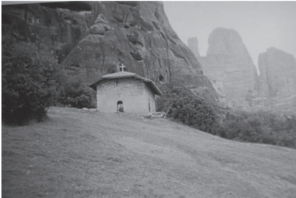
Εικ. 1. Καστράκι Καλαμπάκας, Παναγία Δούπιανης. Άποψη του ναού πριν την αποκατάσταση.
