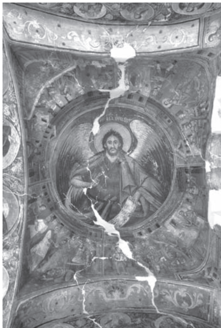
σης παρατηρείται επικάθηση αλάτων, αιθάλης, επιχρίσματα βερνικιών. Εικ. 4β. Αποτέλεσμα μετά τις εργασίες συντήρησης.
