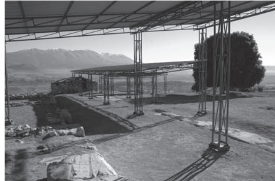
Εικ. 2. Νέα αντιστρέψιμα στέγαστρα προστασίας στον χώρο Σαρανταπόρου.
