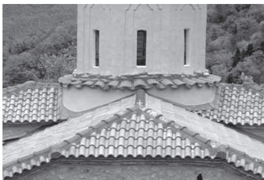
Εικ. 7. Καστανιά Καλαμπάκας. Ι. Μ. Αγ. Νικολάου Σιαμάδων. Άποψη της στέγης του ναού με τον τρούλλο μετά την αποκατάσταση.
