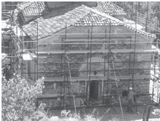
Εικ. 5, 6. Καστανιά Καλαμπάκας. Ι. Μ. Αγ. Νικολάου Σιαμάδων. Εργασίες υποστήριξης – αντιστήριξης εξωτερικά του ναού.
