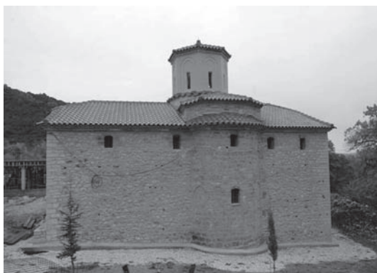
Εικ. 9. Καστανιά Καλαμπάκας. Ι. Μ. Αγ. Νικολάου Σιαμάδων. Άποψη του αποστραγγιστικού δικτύου.
