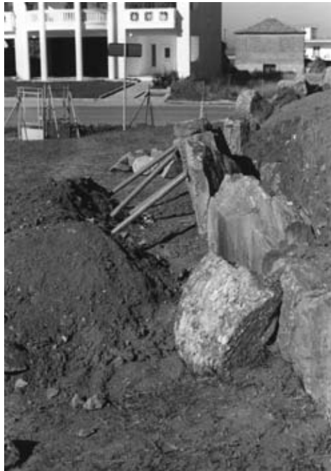
Εικ. 8. Φάρσαλα. Θολωτός τάφος. Επαναφορά στην κατακόρυφη αρχική θέση των λίθων του περιβόλου.
