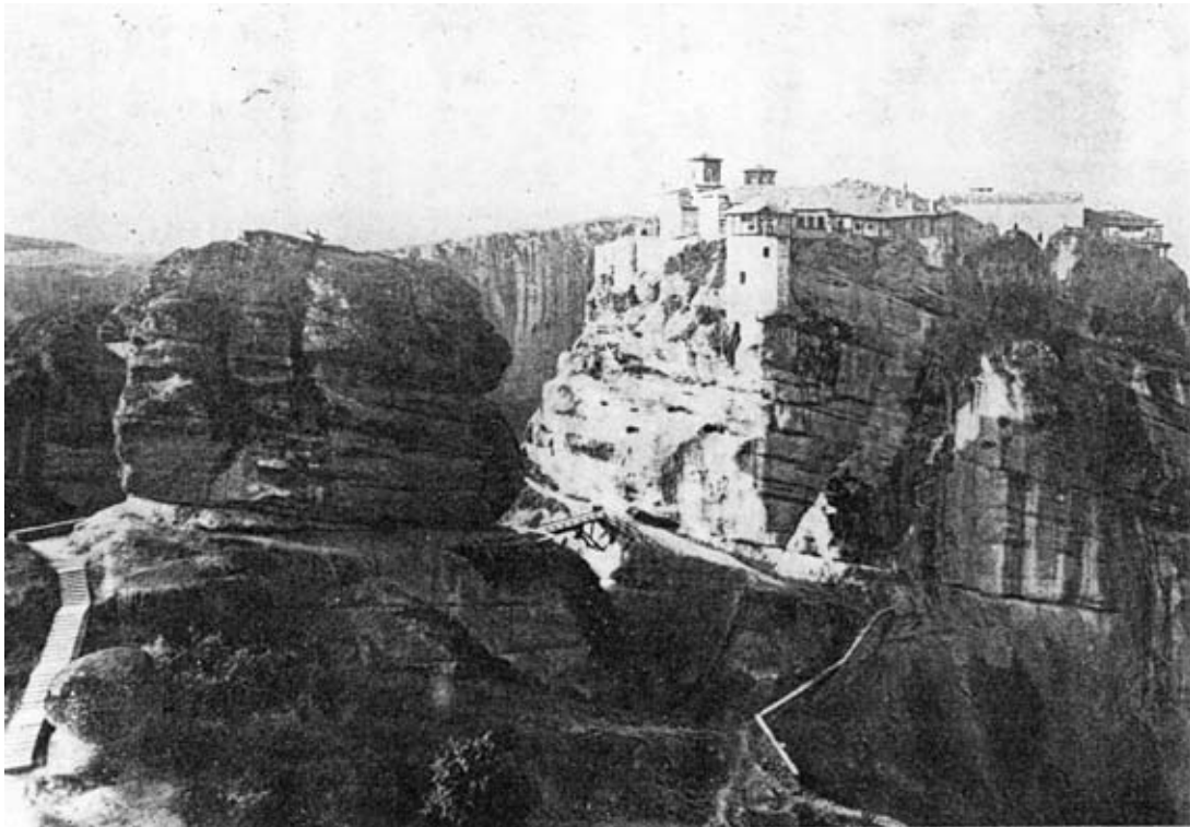
Εικ. 10. Βόρεια γενική άποψη του βράχου της μονής Βαρλαάμ: διακρίνονται οι θέσεις και των Τριών Οδών προσπελάσεως. Από την Τρίτη Οδό, διακρίνονται το αρχικό της τμήμα με τις τσιμεντοβαθμίδες (ανατολικά), η πεζογέφυρα (στο μέσον), καθώς και το νεώτερο – παρακαμπτήριο τμήμα της, του 1921 (βορειοδυτικά).
