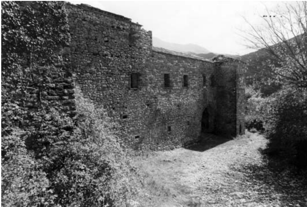
Εικ. 3. Μυρόφυλλο, Ι. Μ. Αγ. Γεωργίου. Η ΒΔ πτέρυγα των κτιριακών εγκαταστάσεων της μονής.
