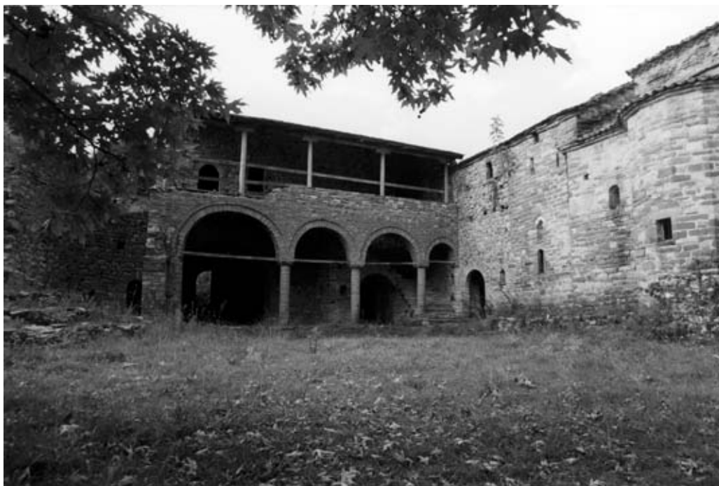
Εικ. 4. Μυρόφυλλο, Ι. Μ. Αγ. Γεωργίου. Άποψη της Δυτικής πλευράς μετά από το πέρας των αναστηλωτικών εργασιών.
