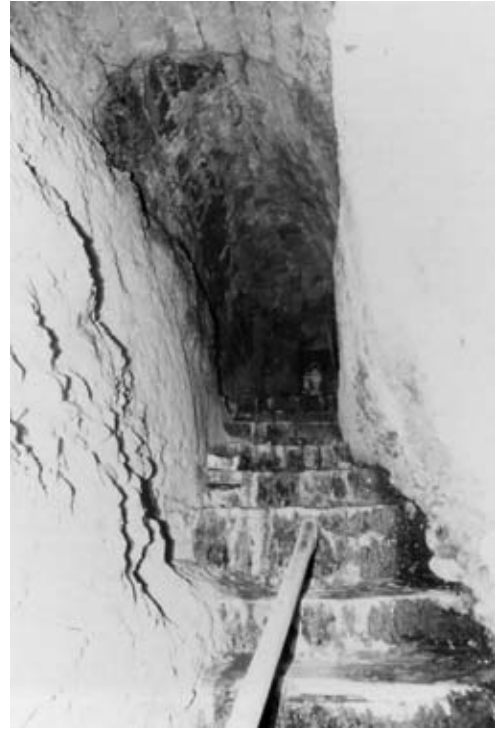
Εικ. 4. Η Πρώτη Οδός προσπελάσεως στη μονή Βαρλαάμ: το τρίτο μέρος της οδού με τη σήραγγα κάτω από την Τράπεζα και την Εστία της μονής.
