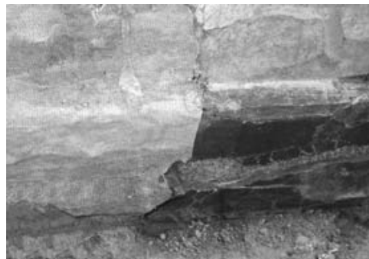
Εικ. 4. Λεπτομέρεια τοίχου 3, στοά 2, στάδιο απομάκρυνσης γαζών με υδατοδιαλυτή κόλλα και καθαρισμού επιφάνειας.
