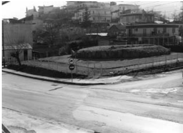
Εικ. 11. Φάρσαλα. Ο θαλαμοειδής και ο θολωτός τάφος μετά την ολοκλήρωση των εργασιών επέμβασης.
