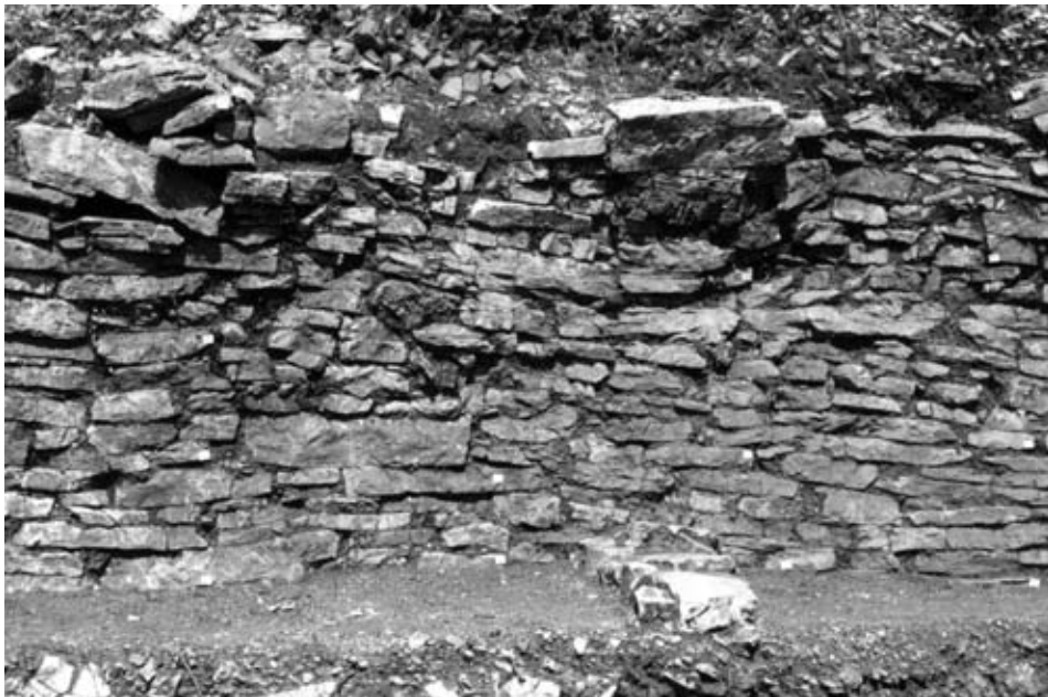
Εικ. 13. Αγριοκέρασο Καρυάς, Εσωτερική όψη του ΒΔ τοίχου του οικήματος Β.
