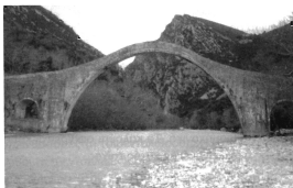
Φωτ. 1.2: Το γεφύρι της Πλάκας στην Άρτα
