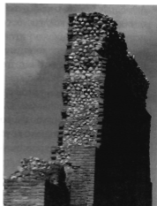
Φωτ. 1.4: Χυτή τοιχοποιία από το Ρωμαϊκό Ωδείο Πατρών
