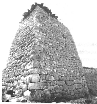
Φωτ. 1.1: Κατάλυμα από Ξηρολιθοδομή 2
