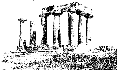
Εικ. 332. Μονόλιθους κίονες είχε και ο αρχαϊκός (γύρω στα 540 π.Χ.) δωρικός ναός του Απόλλωνος (?) στην Κόρινθο, φτιαγμένους από πωρόλιθο (πουρί) ύλη του ναού από ΝΑ (: Gruben, 1966, σ. 95, εικ. 89).
