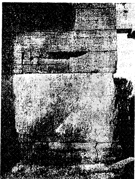
Σχ. 25. Τοιχοβάτης, ὀρθοστάτης καὶ δόμοι τοῦ ναοῦ τῆς Ἥρας (λεγόμενου «Ποσειδῶνος») τῆς Ποσειδωνίας. (Φωτογραφία τοῦ συγγραφέως).
