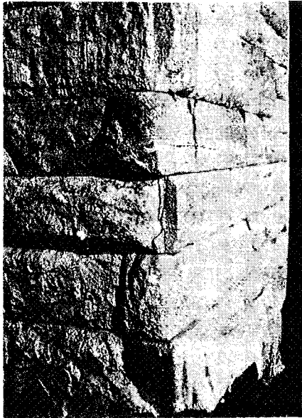
Σχ. 80. Ἰσόδομον κοφωτὸν σύστημα. Ἀνυλημματικὸς τοῦχος τοῦ θεάτρου εἰς Δῆλον. (Φωτογραφία τοῦ συγγραφέως).
