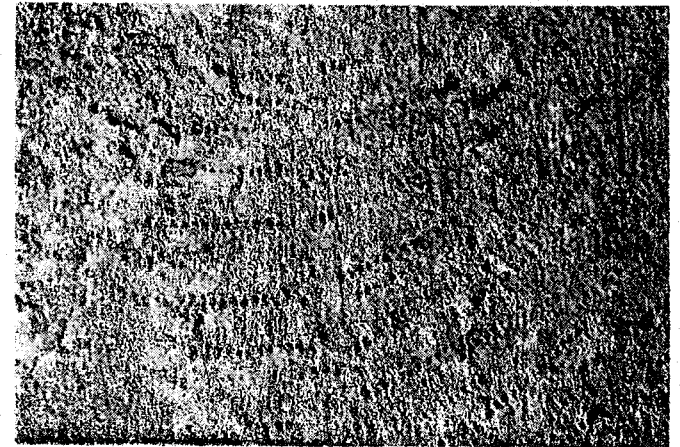
Σχ. 82. Ἰγνη κατεργασίας τῆς ἐπιφανείας ἐκ πωρολίθου μέλους τοῦ ναοῦ τοῦ Ἀπόλλωνος εἰς Κόρινθον. (Φωτογραφία τοῦ συγγραφέως).
