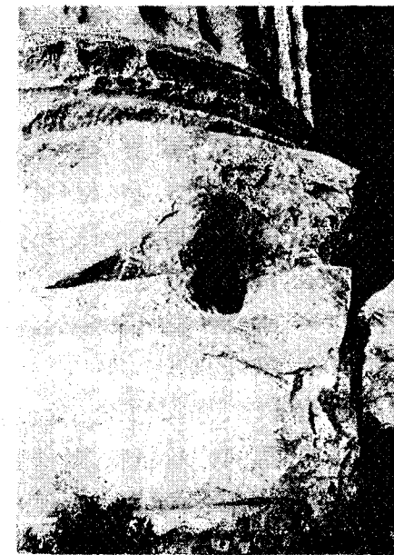
Σχ. 66. Βάθβυρος μεταχείρισις τῆς βάσεως κίονος τοῦ ναοῦ τοῦ Ὀλυμπίου Διὸς εἰς Ἀθήνας, πρὸς λήψιν τῶν μετάλλων τῶν γόμφων, σιδήρου καὶ μολύβδου. (Φωτογραφία τοῦ συγγραφέως).
