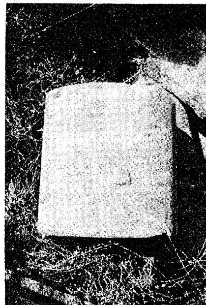
Σχ. 85. 'Αποκεικρουμένος τεκτονικός άγκών εις λίθον της κρηπίδος της Στοάς του Φίλωνος. Τελεστήριον 'Ελευσίνος. (Φωτογραφία του συγγραφέως).
