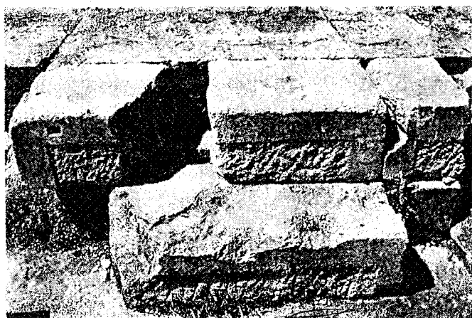
Σχ. 97. 'Αναθήσασις λίθων στρώματος. Ναὸς τοῦ 'Απόλλωνος εἰς Δελφοὺς. (Φωτογραφία τοῦ συγγραφέως).
