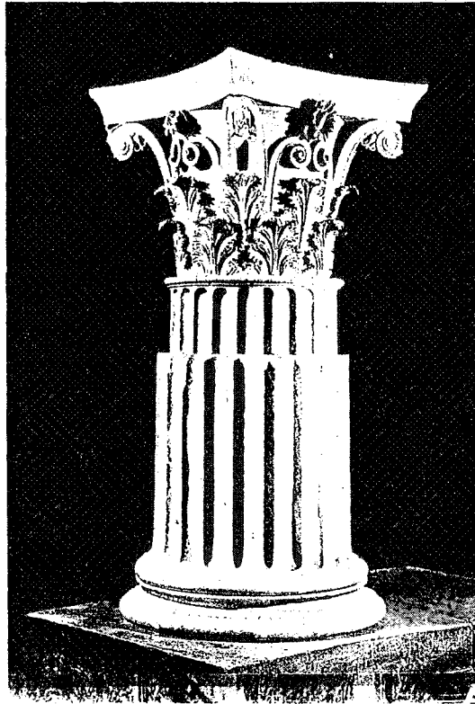
Εικ. 484. Θόλος Επιδαύρου, περ. 360-320 π.Χ. Από τον κορινθιακό κίονα: το παραδειγματικό κιονόκιονο, τμήμα ακαπύτου και κατωπύτου σφονδύλου, η -ουσιαστικά- ιωνική αττική βάση, μέρος στυλοβάτη (: Papahatzis, 1978, σ.(151), εικ. 119).
