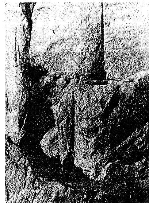
Εικ. 44. Δίδυμα, ναός του Απόλλωνα: κάθετη αύλακα μολυβδοχόησης στον τοίχο του σηκού.
