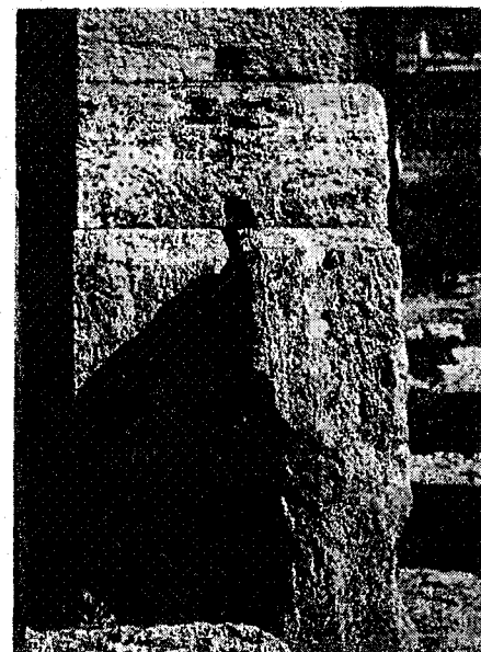
Σχ. 26. Ὄρθοστάτης καὶ ἀντίθημα, ὡς καὶ διαμπερεῖς δόμοι τοῦ ναοῦ τῆς Ἥρας (λεγόμενου «Ποσειδῶνος») τῆς Ποσειδωνίας. (Φωτογραφία τοῦ συγγραφέως).
